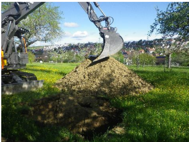
Foto 3: Aushub von BSCH 1
