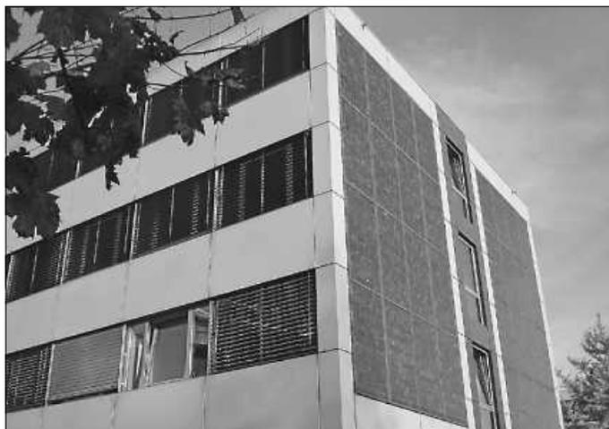
Photovoltaikanlagen an Fassaden können eine sinnvolle Ergänzung zu Anlagen auf dem Dach sein. Foto: pixabay
